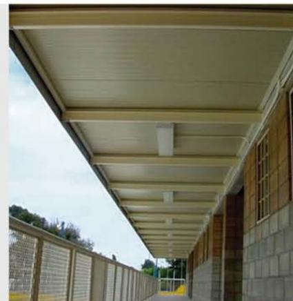
Panel formado por dos hojas de acero prepintado, con un núcleo de espuma de poliuretano al centro.
