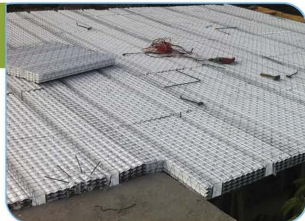
Paneles estructurales resistentes a cortantes de sismos intensos y a empujes de vientos intensos. Diseñados para construir los muros de carga más resistentes y aislantes. Se recomienda utilizarlo para losas de entrepiso y azotea.
