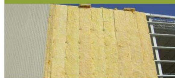
Es un rollo flexible de aislamiento térmico, fabricado con fibras de vidrio aglutinadas con resinas termofijas recubierta con una barrera de vapor en una de sus caras.
