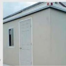
Panel con núcleo de poliuretano con cara exterior de lámina pintada e interior en vinil blanco reforzado, utilizado para muros y plafones.
